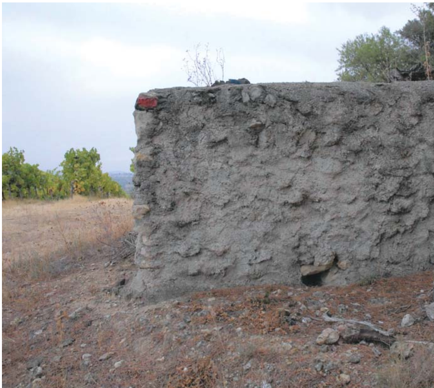
Pour les garennes, les chasseurs n'ont pas lésiné, ils ont construit de véritables bunkers en béton.
