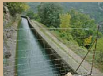
Le canal de Madières sécurisé.
